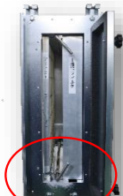
④ オリジナルロックと プレロックを左右に倒し フィルターをロックします
